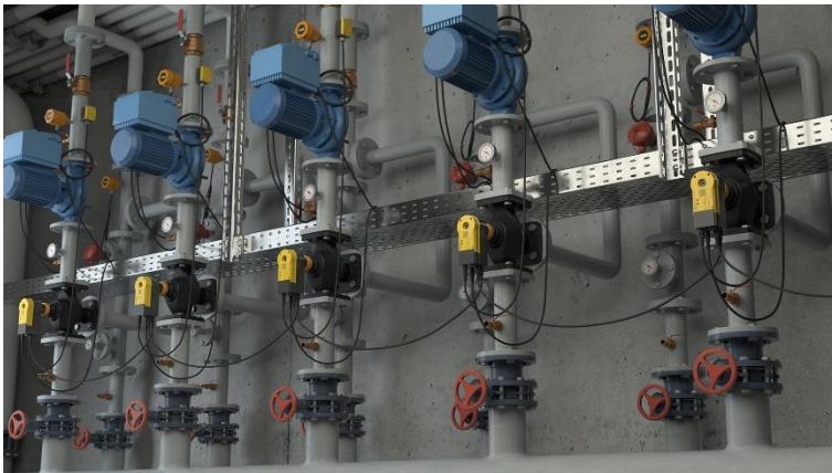
Visualisierung einer Heizgruppe auf Grundlage des Smart Actuator BIM-Modells
