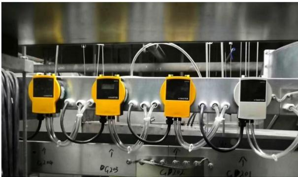
Image : Transmetteurs de de pression différentielle SAUTER (EGP 100) pour le contrôle et la surveillance de la pression ambiante installés au sein de l'usine de production de vaccins Sinopharm
